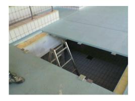
Unterwasser-Konstruktion zur Höhenverstellung des Schwimmbeckenbodens. Korrosionsschutz, ganzjährig unter Wasser. Bisher jährlich Neuanstrich in den Sommerferien
